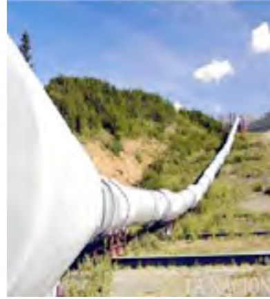
GASEODUCTO ( gas pipeline )
